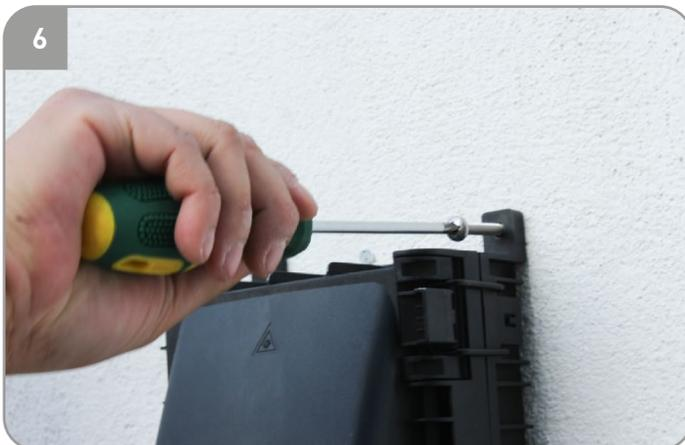
Colocar la terminal sobre los orificios e instalar los tornillos en los 4 puntos con ayuda del desarmador.
