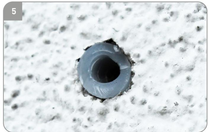
Instalar los 4 taquetes de plástico en los 4 orificios y los ajustar con la ayuda del martillo.
