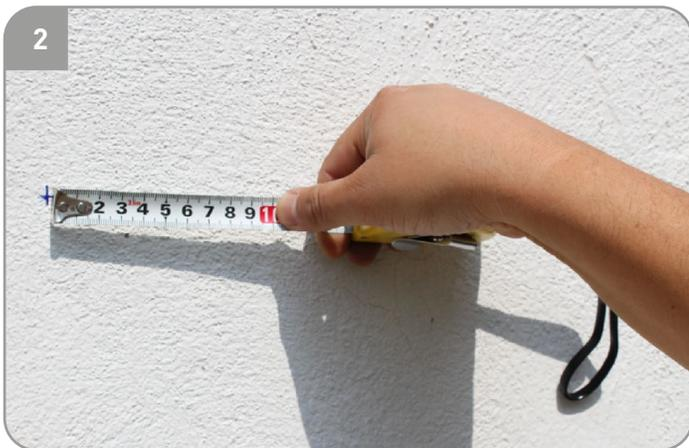
Marcar sobre el muro donde se desea instalar la terminal considerando las medidas previamente indicadas.
