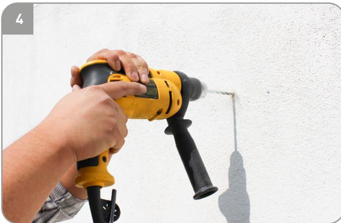
Con la ayuda del taladro, perforar el muro en las 4 marcas utilizando una broca para concreto de 3/8" a una profundidad de 4.5 cm.
