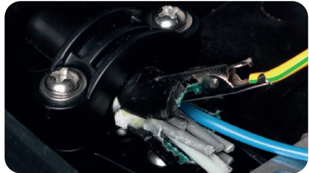
**b.** Instalar el extremo opuesto en la terminal de tierra del cierre de empalme.
